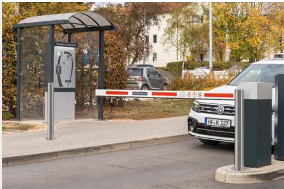
Anlagenschutz außen, z. B. Kassenautomaten, Schranken, E-Ladesäulen
