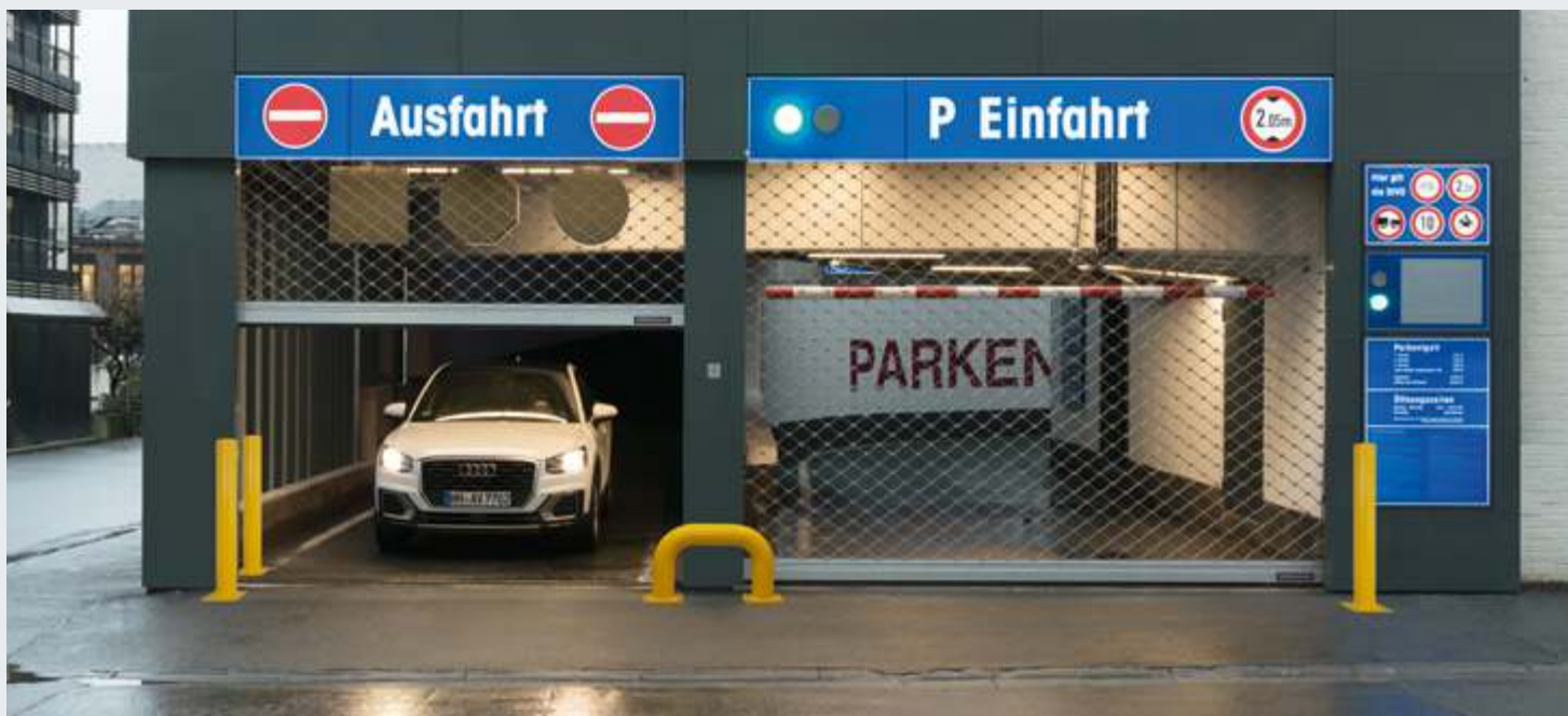
Gebäude- und Anlagenschutz außen
