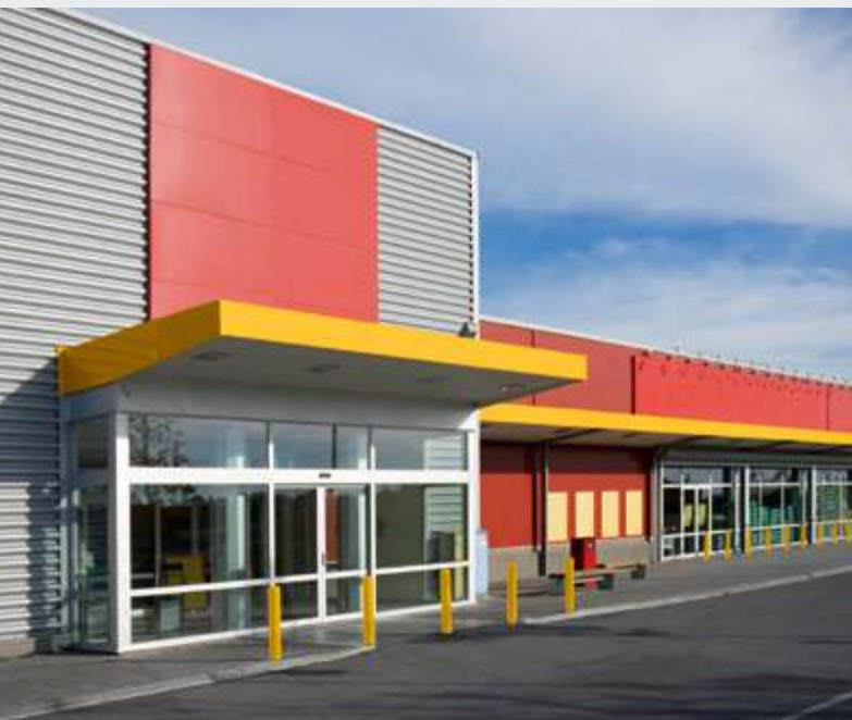
Gebäude- und Anlagenschutz außen
